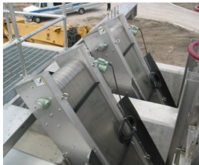
Enviroquip FS Screen In-Channel; .5 MGD – 1 MGD
